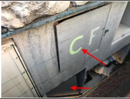
Photo n° PhA003 Localisation : Parties extérieures Ouvrage : Bardages et façades légères Partie d'ouvrage : Plaques (fibres-ciment) Description : Plaques (fibres-ciment) Localisation sur croquis : ZPSO-003
