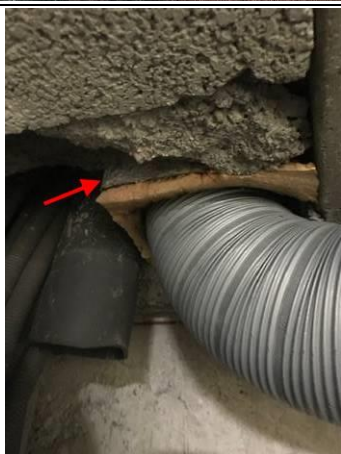
Photo n° PhA002 Localisation : Rez de chaussée - Vide sanitaire Ouvrage : Conduits de fluides (air, eau, autres fluides) Partie d'ouvrage : Conduits Description : Conduits fumée gaz Localisation sur croquis : ZPSO-002
