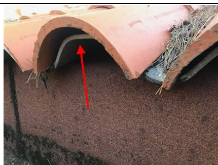
Photo n° PhA001 Localisation : Parties extérieures Ouvrage : Toitures Partie d'ouvrage : Plaques (fibres-ciment) Description : Plaques (fibres-ciment) Localisation sur croquis : ZPSO-001
